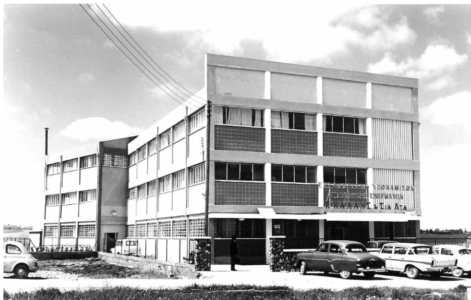
Το κτήριο του πρώτου ιδιόκτητου εργοστασίου στην περιοχή ΣΟΠΑΖ.
